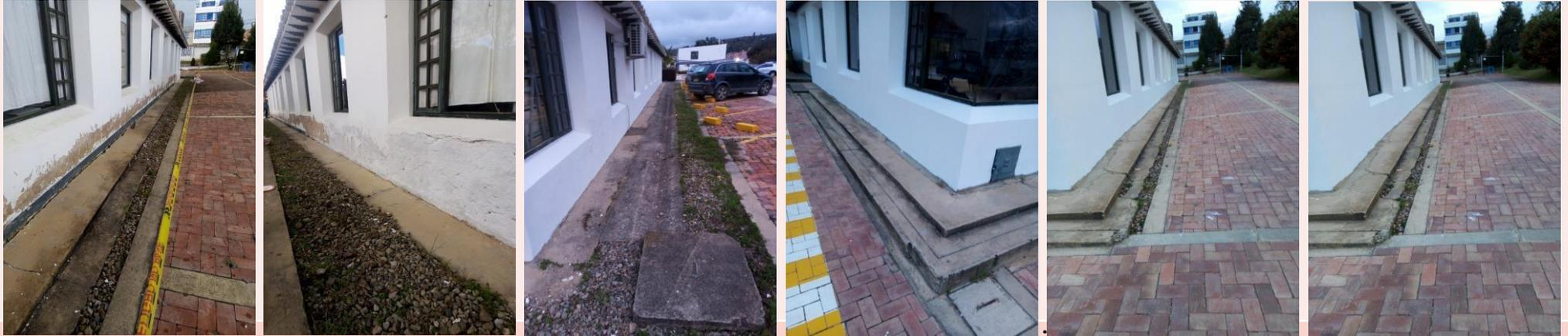
PROCESO COMPLETO, RETIRAR MATERIAL EXISTENTE, RESANE, APLICACIÓN IMPERMEABILIZANTE PARA CAPILARIDAD, ACABADO IGUAL O SIMILAR AL EXISTENTE
