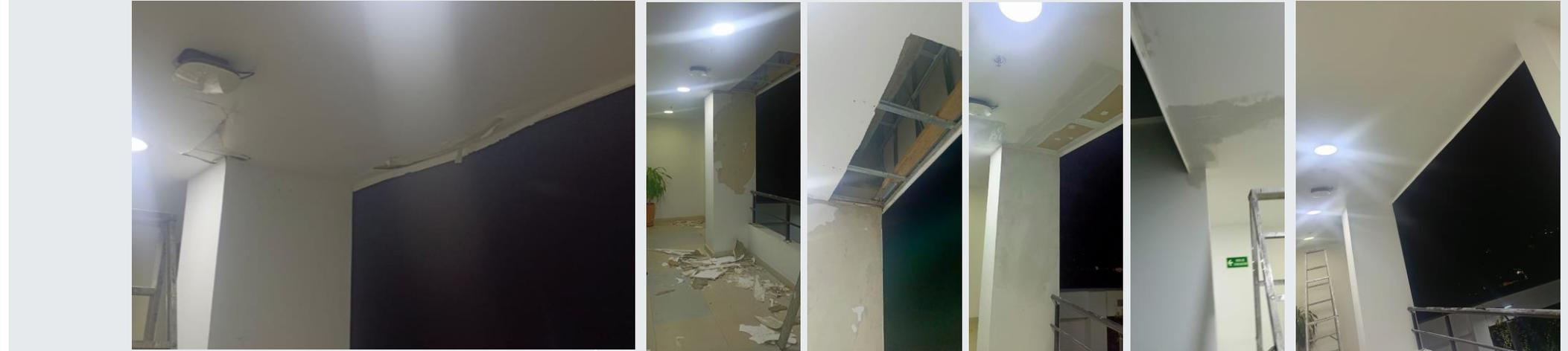
PROCESO COMPLETO, RETIRAR MATERIAL EXISTENTE, RESANE, APLICACIÓN IMPERMEABILIZANTE PARA CAPILARIDAD, ACABADO IGUAL O SIMILAR AL EXISTENTE
