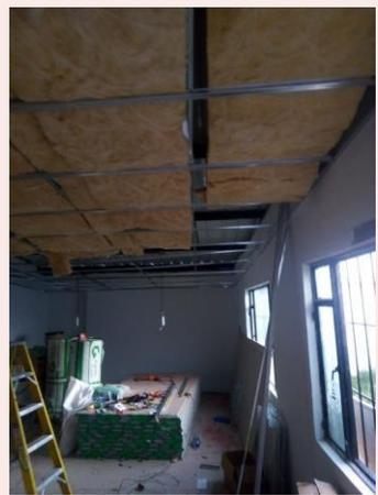
Se instala la estructura, la frescasa y por ultimo las láminas para el cielo raso de inclusión social
