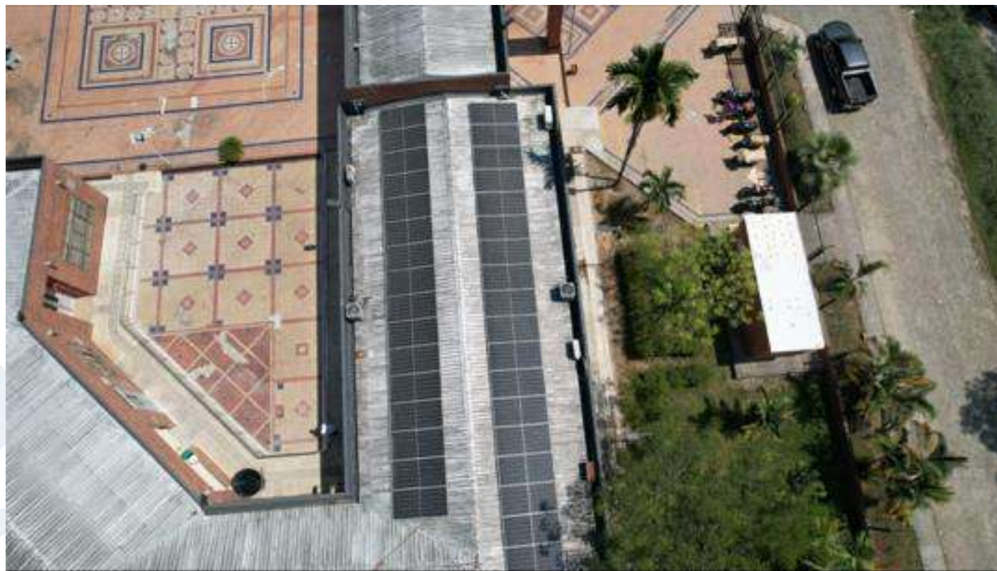
Sistemas Fotovoltaico instalado en el CEAD Acacias Fuente: Gerencia de Infraestructura Física, 2023
