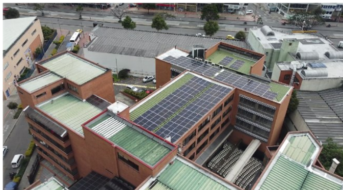
Imagen Sistema fotovoltaico Instalado en Sede Nacional JCM (UNAD, octubre 2022).
