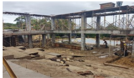
Imagen Construcción CNI Arbeláez (UNAD, noviembre 2022).
